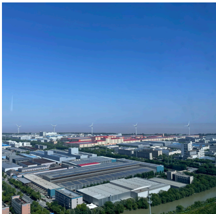
嘉兴示范区的屋顶光伏及风电
